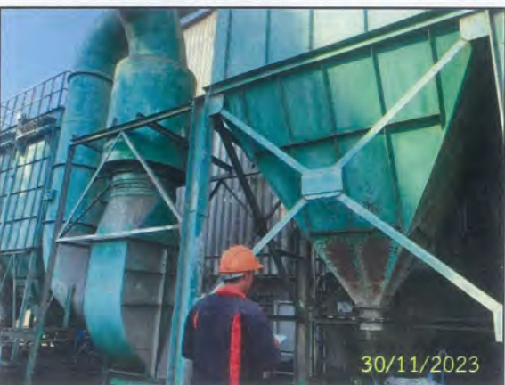
เจ้าหน้าที่ตรวจสอบสภาพและบำรุงรักษาระบบกำจัดฝุ่น (Bag Filter)
