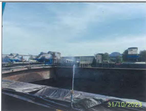
มีการติดตั้งระบบฉีดพ่นน้ำให้ความชื้นกับถ่านหิน
