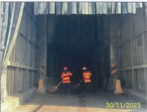
พนักงานคอยตรวจสอบอุปกรณ์ดักฝุ่น และทำความสะอาดสม่ำเสมอ
