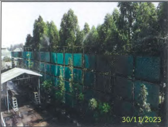
จ) ติดตั้งระบบระบบสเปรย์น้ำ เพื่อป้องกันฝุ่นละออง
