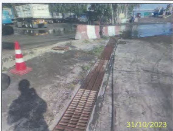
ระบบรวบรวมน้ำบริเวณพื้นที่ขนถ่ายถ่านหินลงสู่บ่อตกตะกอน
