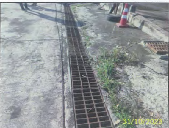
ระบบรวบรวมน้ำบริเวณพื้นที่ขนถ่ายถ่านหินลงสู่บ่อตกตะกอน
